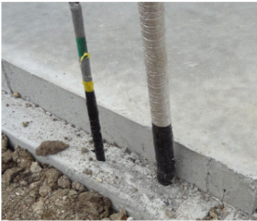
🏠 Post slab pour conduit wrap
