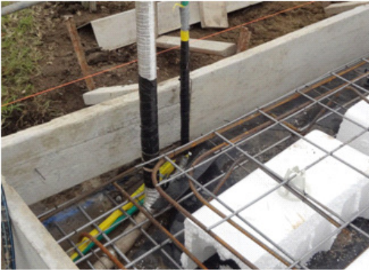
🏠 Pre slab pour conduit wrap
