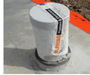
showing post slab pour
